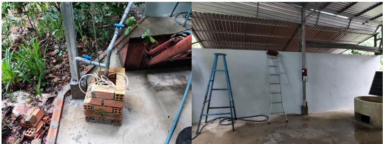
Hình 1.23: Giếng khoan và bể chứa nước diện tích 50m 2 , kết cấu BTCT
