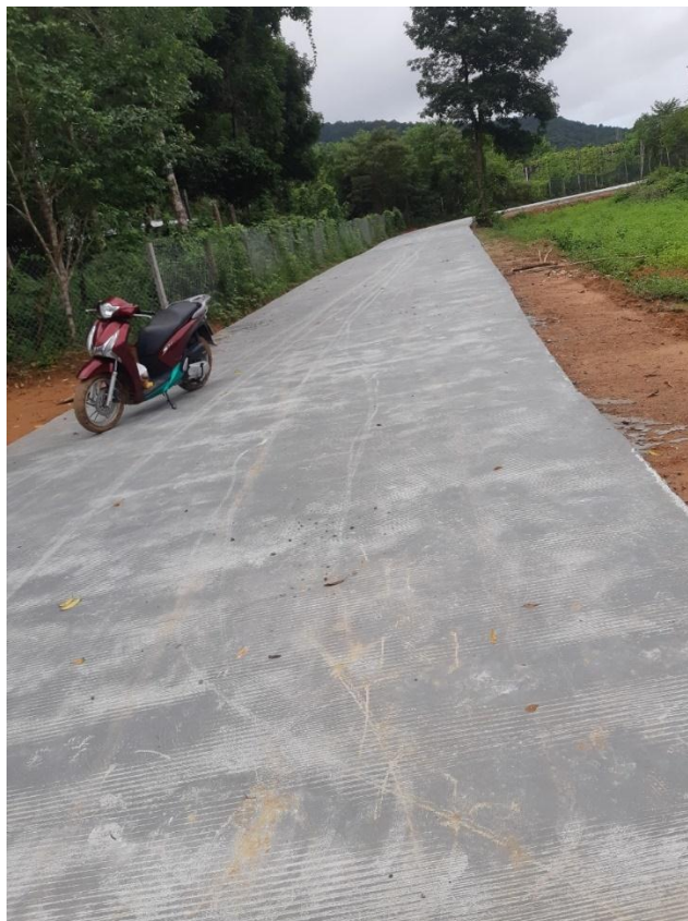
Hình 1.5: Đoạn tuyến kết nối với dự án kết cấu BTXM, nền đường rộng 6m
