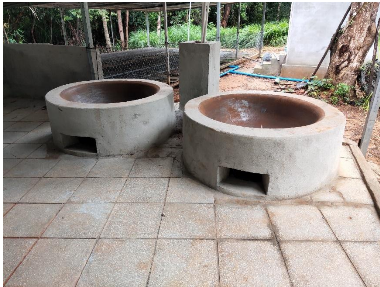
Hình 1.10: Hai chảo thép đường kính 1,2m dùng để đun nước sôi dự phòng khi lò hơi gặp sự cố
