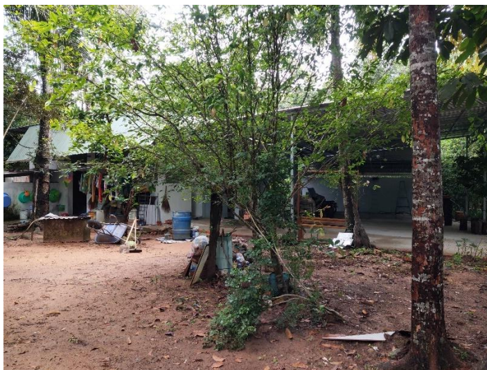
Hình 1.20: Khu vực nhà ở nhân viên, phòng thú y với kết cấu nhà cấp IV, mái lợp tole kẽm 4zem
