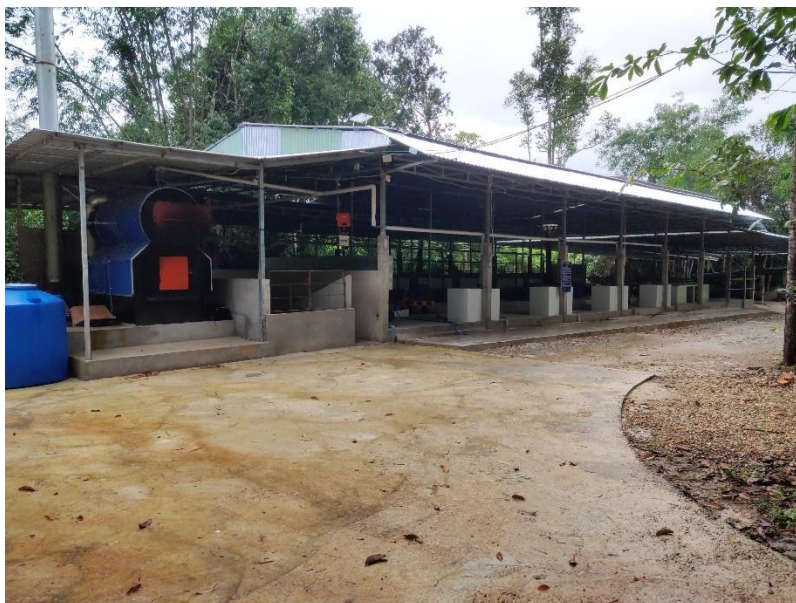
Hình 1.6: Khu nhà xưởng đã được thi công
